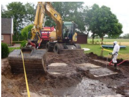
Figuur 5-4: Sanering van een met asbest verhard erf in de regio Goor.
